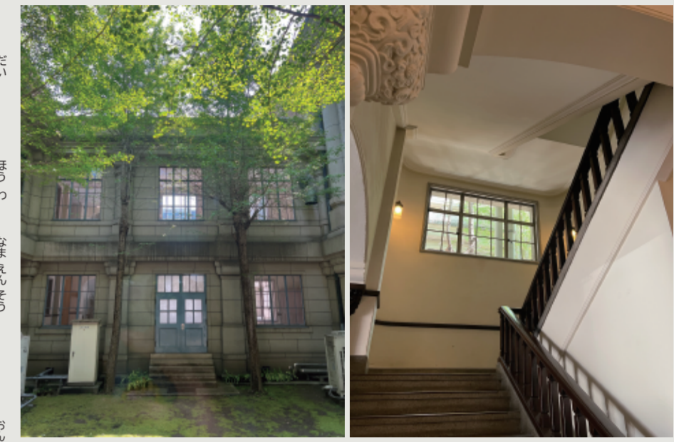
窓からみる中庭 近代建築～和洋折衷な階段
